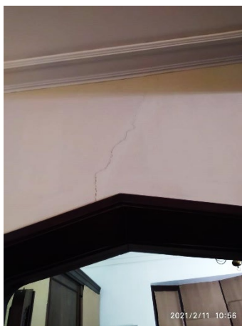
Fotografías 18, 19, 20, 21 y 22 – Grietas en algunos muros que se localizan desde el borde de los vanos de puertas del primer y segundo piso tomadas al interior del inmueble patrimonial. (Fecha de toma de la imagen 11 de febrero de 2021 ).
