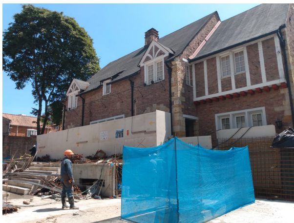
Fotografía 17 – Cerramiento provisional para la protección del inmueble patrimonial. (Fecha de toma de la imagen 11 de febrero de 2021 ).
