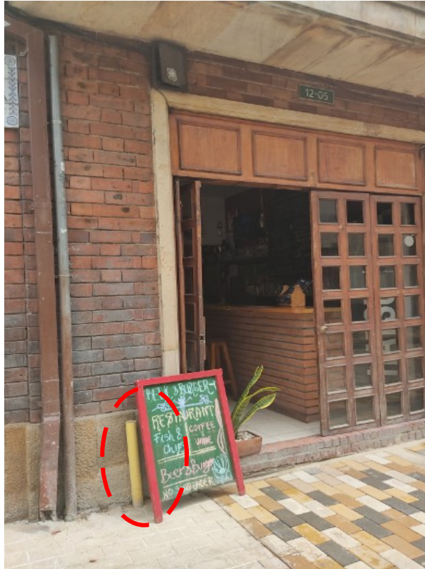
Fotografía 1, Fachada principal del inmueble de la Carrera 4 No. 12-05, se observa instalación de punto provisional para el servicio de gas natural frente a la fachada.
