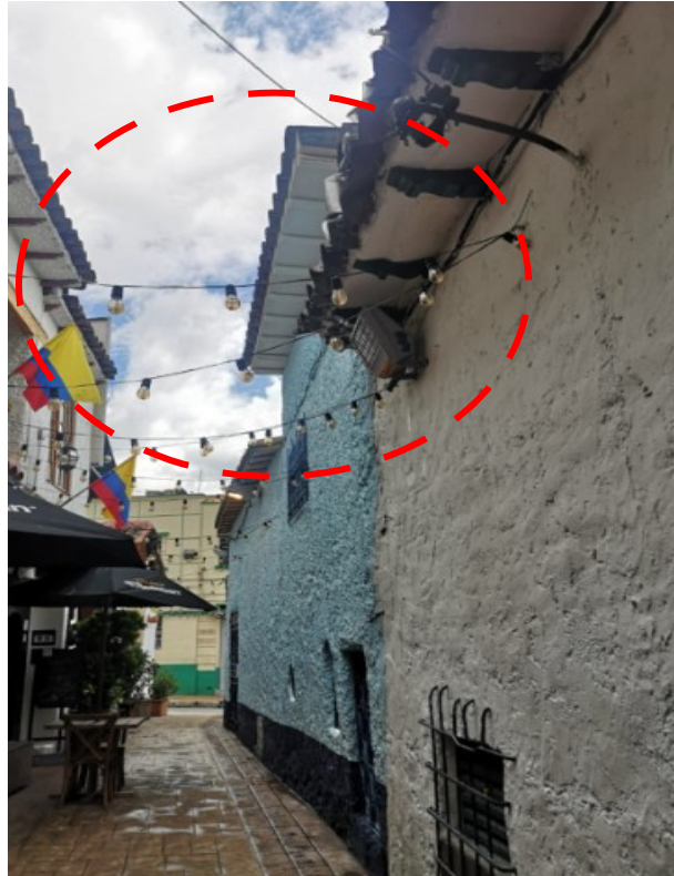
Fotografía 3: Se instalación de bombillos ubicadas en espacio público frente al inmueble de la Carrera 1A No. 12B – 04/12. (Fecha de toma de la fotografía: 3 de junio de 2021)
