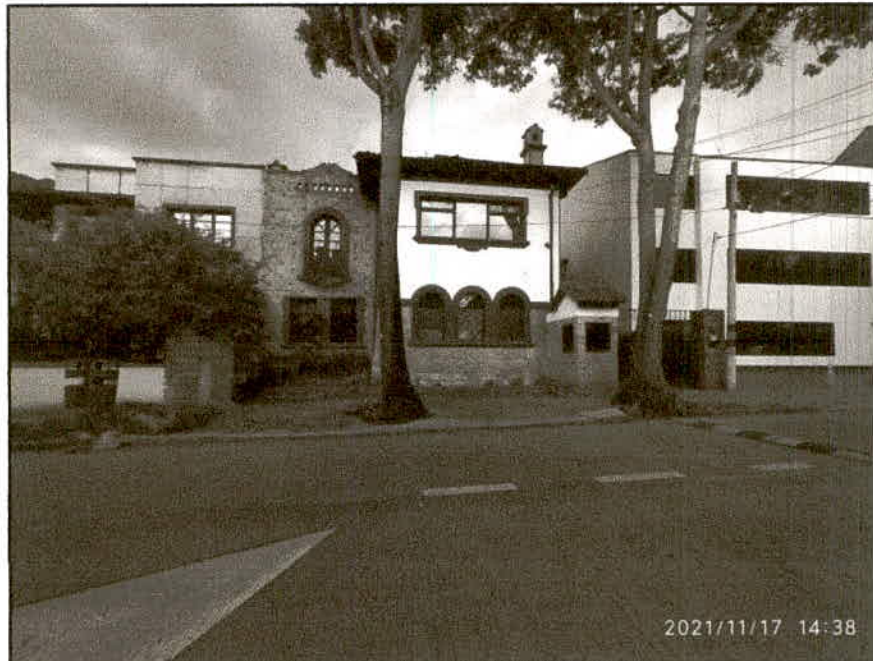
Fotografía 5 – Fachada principal inmueble KR 6 34 70. (Fecha de toma de la imagen 17 de noviembre de 2021).
