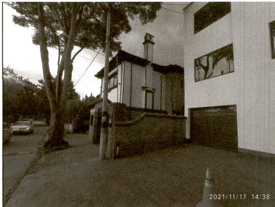
Fotografía 6 – Fachada lateral en el acceso del inmueble KR 6 34 70. (Fecha de toma de la imagen 17 de noviembre de 2021).
