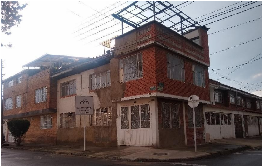
Fachada del predio de la Carrera 57 B No. 67-35
