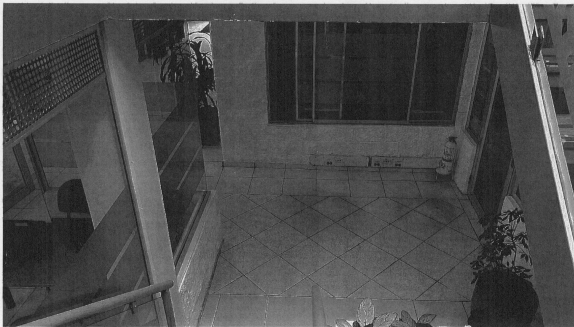
PREDIO 2: Parte posterior del inmueble en el cual se encuentra escalera que conduce a las oficinas de la segunda planta de la edificación.
