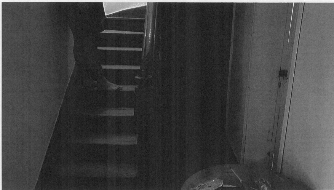
PREDIO 3: Parte posterior del inmueble en el cual se encuentra escalera que conduce a las habitaciones localizadas en el segundo piso.
