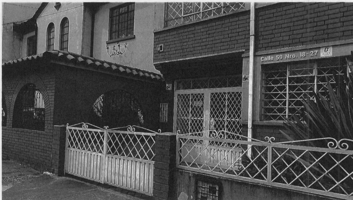
PREDIO 1: A este inmueble no fue permitido el ingreso; se tuvo conocimiento en la visita de que este inmueble hace parte de la empresa que funciona en el inmueble de la Calle 58 B No. 18 – 30/36. Fotografía 2 - Fecha de toma de la imagen: 26 de julio del 2019.
