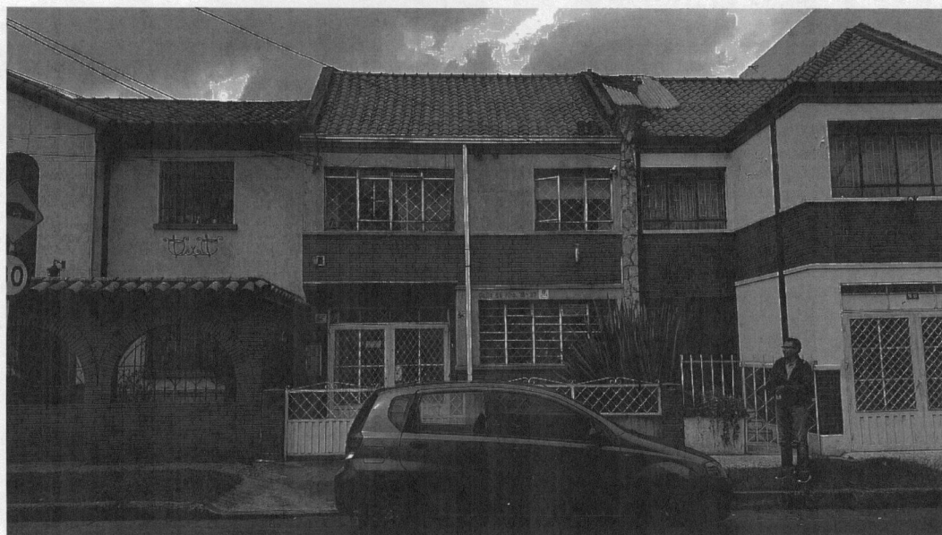
PREDIO 1: Fachada inmueble localizado en la Calle 59 No. 18 – 27. Fotografía 1 - Fecha de toma de la imagen: 26 de julio del 2019.
