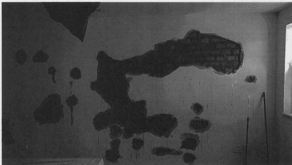
PREDIO 3: Desde el interior se evidencia realización de impermeabilización en muro que colinda con el predio de la Calle 58 B No. 18 – 30/36.
