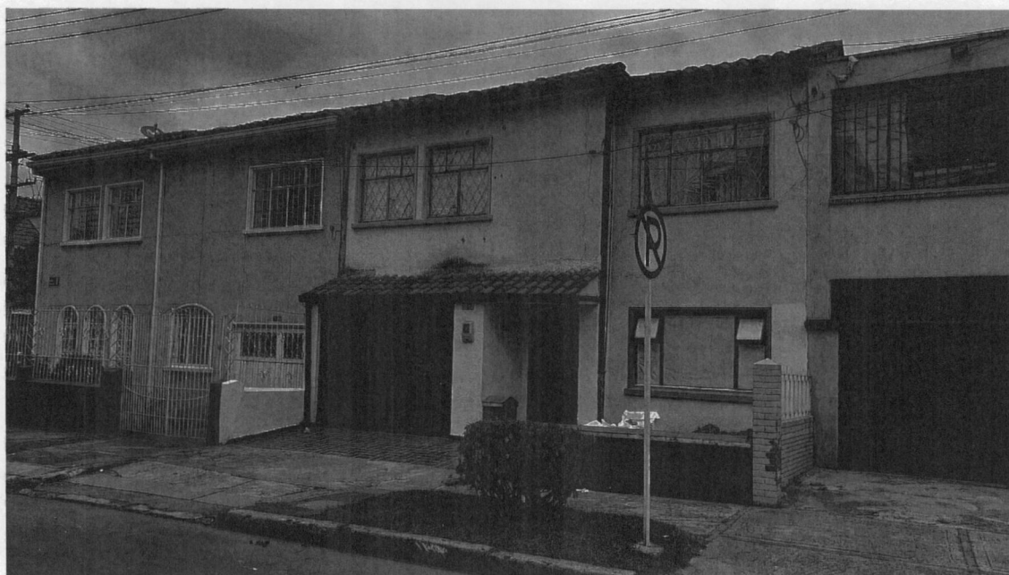
PREDIO 3: Vista desde el costado oriental del inmueble localizado en la Calle 58 B No. 18 – 40/42. Fotografía 13 - Fecha de toma de la imagen: 26 de julio del 2019.
