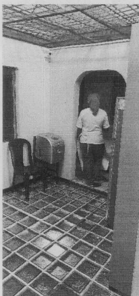
Fotografía 12. Área de segundo piso donde se observa piso en vitrobloc, sobre el área origina de patio. Fecha fotografía: abril 25 de 2019.
