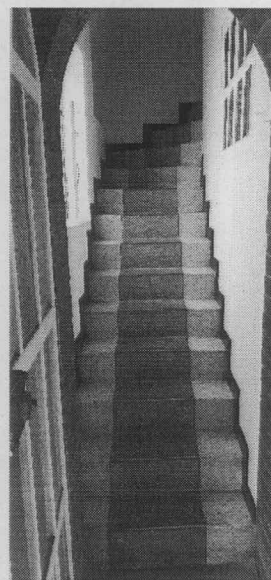
Fotografía 4. Escalera hacia segundo piso, localizada al interior de muro de fachada. Fecha fotografía: abril 25 de 2019.
