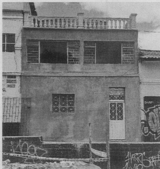
Fotografía 3. Estado actual de fachada, donde se observa capa de pañete sobre toda la superficie. En la fotografía ya no se observa vano lateral oriental de acceso. Fecha fotografía: abril 25 de 2019.
