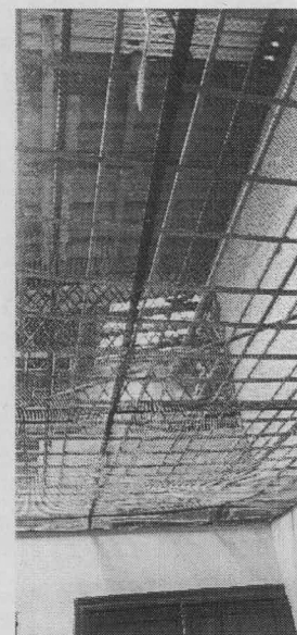
Fotografía 13. Vista de espacio superior o tercer piso, tomada desde el segundo piso y se evidencia reja metálica.. Fecha fotografía: abril 25 de 2019.
