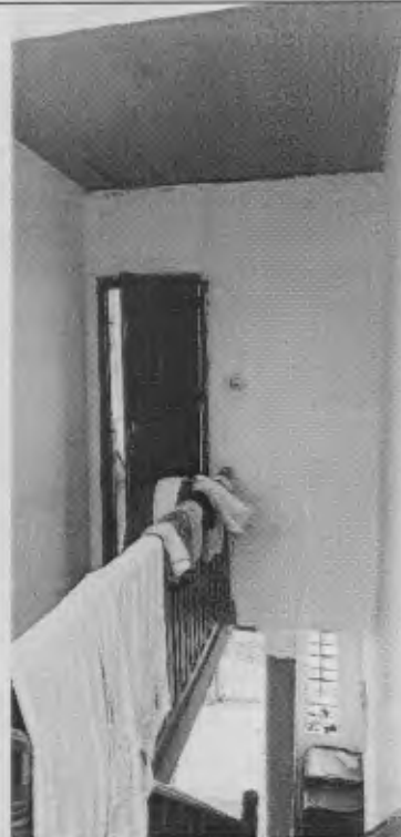
Fotografía 11. Área de punto fijo, al fondo baño en segundo piso. Fecha fotografía: mayo 21 de 2019
