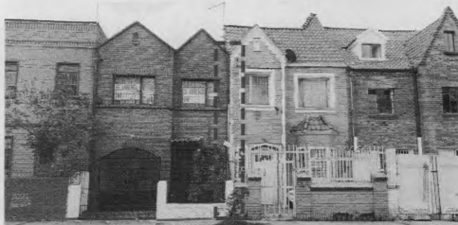
Fotografía 19. Localización de bajante de aguas lluvias, compartida entre los predios de la calle 65 No. 15 A – 17 y calle 65 No. 15 A - 23. Fecha fotografía: mayo 21 de 2019.
