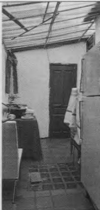
Fotografía 10. Hall de segundo piso cubierto con teja translúcida la cual desagua hacia canal compartida con el predio de la CL 65 No. 15 A - 17. Fecha fotografía: mayo 21 de 2019
