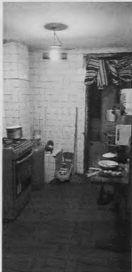
Fotografía 6. Estado de la cocina en primer piso. Fecha fotografía: mayo 21 de 2019
