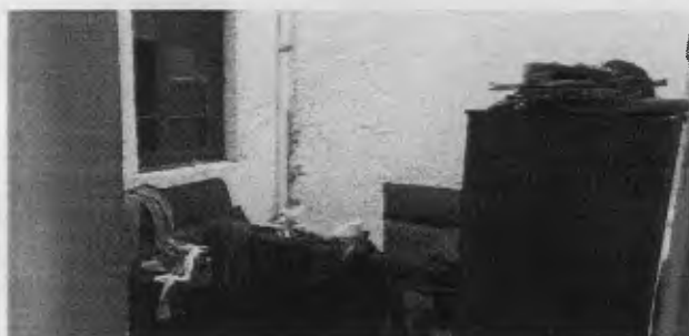
Fotografía 8. Estado de patio cubierto con teja plástica translúcida en primer piso. Fecha fotografía: mayo 21 de 2019
