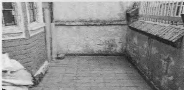
Fotografía 2. Área de antejardín donde se observa el cerramiento y el estado de mantenimiento. Fecha fotografía: mayo 21 de 2019
