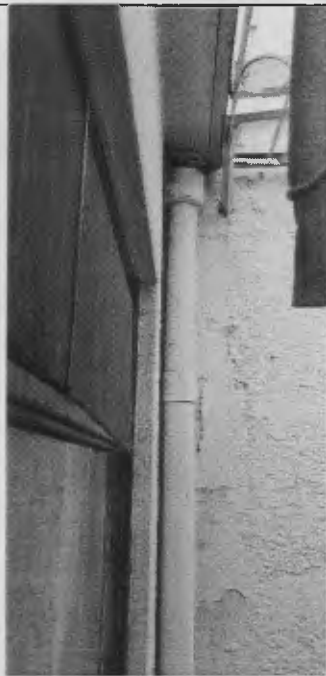
Fotografía 17. Estado de las canales y bajantes en tubería PVC en funcionamiento y buen estado. Fecha fotografía: mayo 21 de 2019
