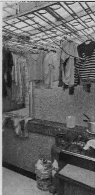
Fotografía 14. Área de patio en segundo piso en el cual se observa cubierta den teja traslúcida y reja metálica. Fecha fotografía: mayo 21 de 2019
