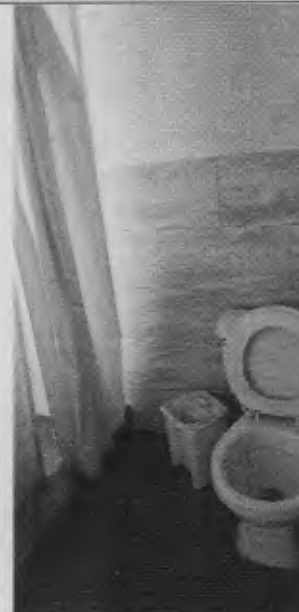
Fotografía 13. Baño de segundo piso al cual se le realizó el cambio de acabados. Fecha fotografía: mayo 21 de 2019
