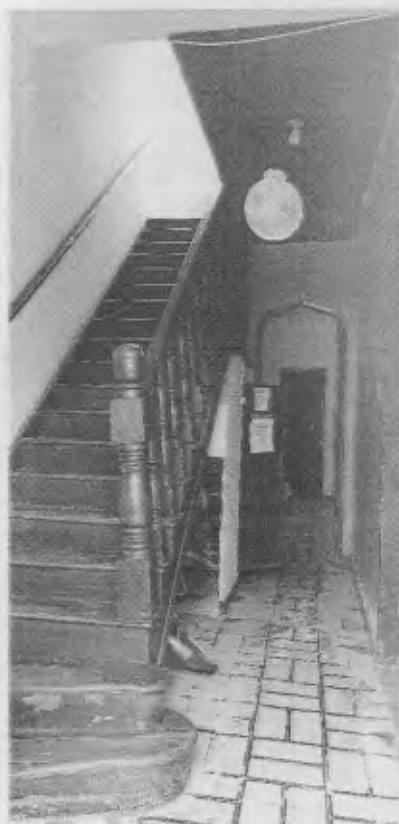
Fotografía 4. Acceso al inmueble donde se observa escalera principal y hall hacia costado posterior. Fecha fotografía: mayo 21 de 2019
