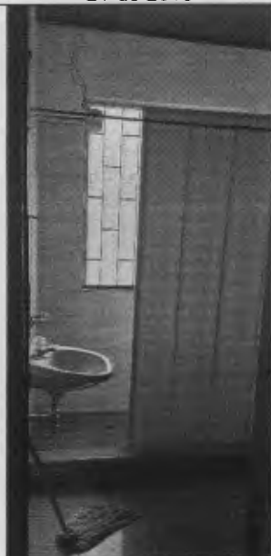
Fotografía 12. Baño de segundo piso al cual se le realizó el cambio de acabados. Fecha fotografía: mayo 21 de 2019
