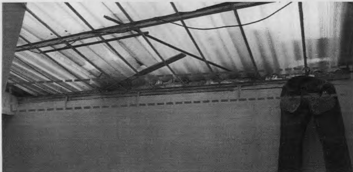
Fotografía 16. Estado cubierta en hall de segundo piso, donde se observa canal metálica compartida con el predio colindante de la calle 65 No. 15 A – 17, la cual se encuentra en buen estado. Fecha fotografía: mayo 21 de 2019
