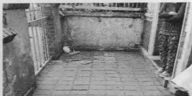
Fotografía 3. Área de antejardín donde se observa el cerramiento y el estado de mantenimiento. Fecha fotografía: mayo 21 de 2019
