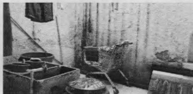
Fotografía 9. Patio posterior. Área de lavado. Fecha fotografía: mayo 21 de 2019
