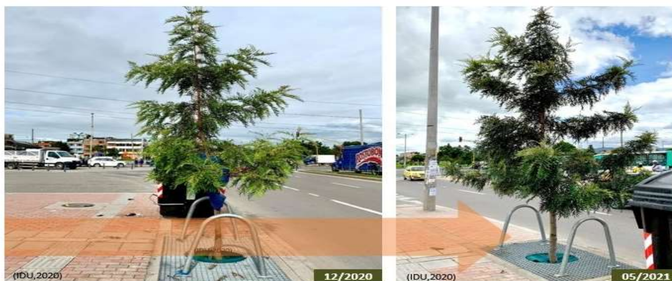
Registro de un alcorque inundable con un Robe Australiano sobre un andén de la ciudad. Fuente: IDU.
