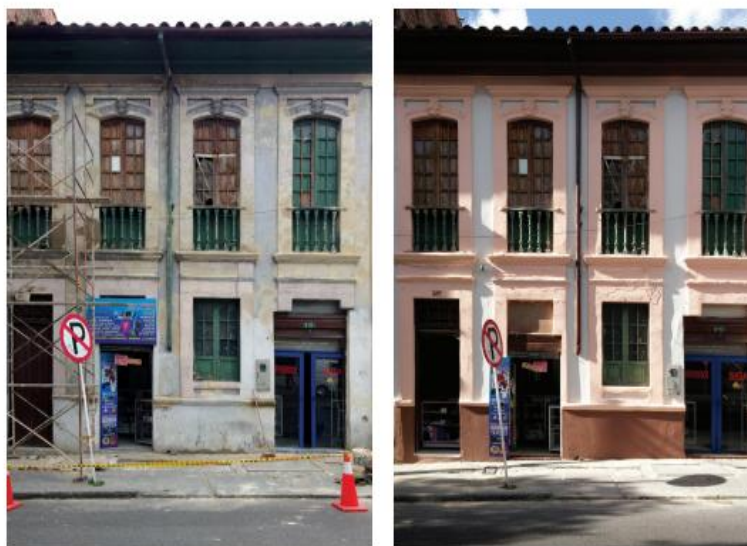
Antes y después del enlucimiento de un inmueble en La Candelaria. Fotografía: Equipo Candelaria es Tu Casa - IDPC.
